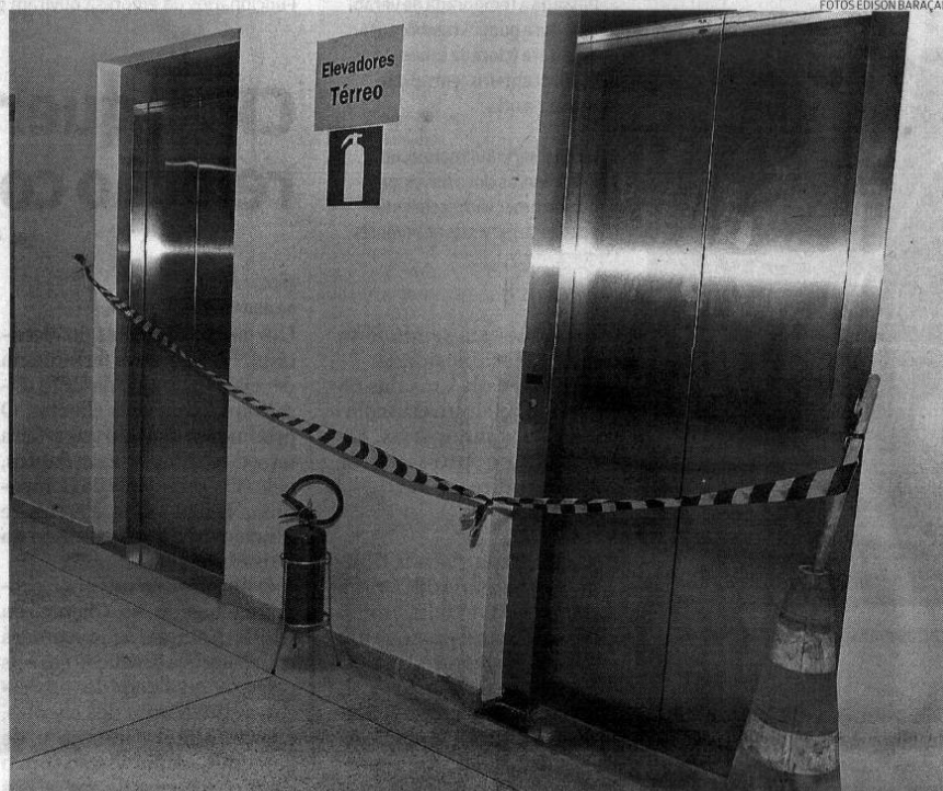
O elevador do Paço ficou interditado ainda no período da manhã e passará por inspeção técnica em breve
